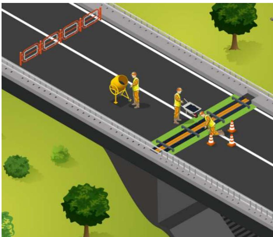
L’opération consiste à retirer les joints de chaussées et à réparer les bétons sous l’ouvrage, puis à repositionner de nouveaux joints de chaussées sur la voie de circulation et la bande d’arrêt d’urgence de l’ouvrage, dans le sens Tours vers le Mans, au niveau de la bifurcation entre l’A10 et l’A28 au nord de Tours.
