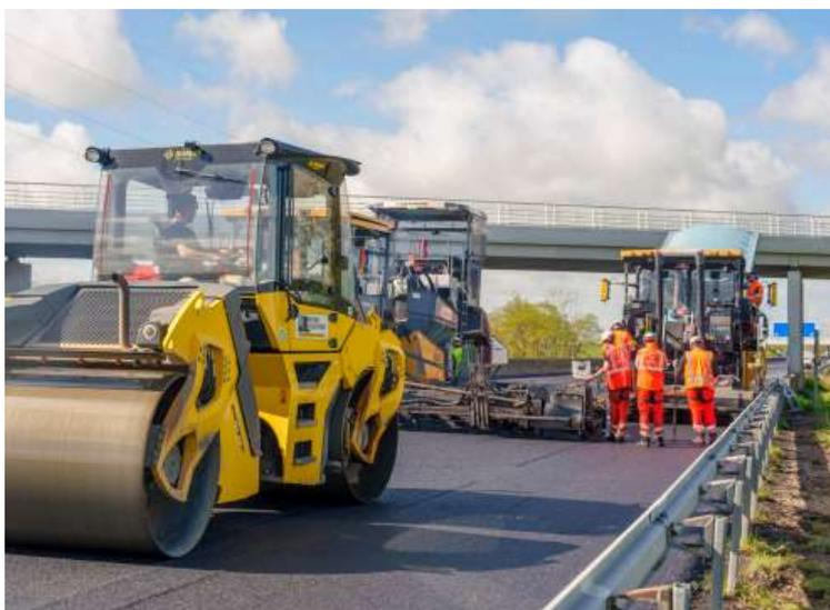
Ces travaux d’entretien de la chaussée entre la bifurcation A28 sud / A11 et l’échangeur de la Ferté-Bernard (n°5) visent à renforcer le confort de conduite et la sécurité des usagers qui empruntent cette section, et sont partie intégrante du programme de rénovation des chaussées sur l’autoroute A11.
