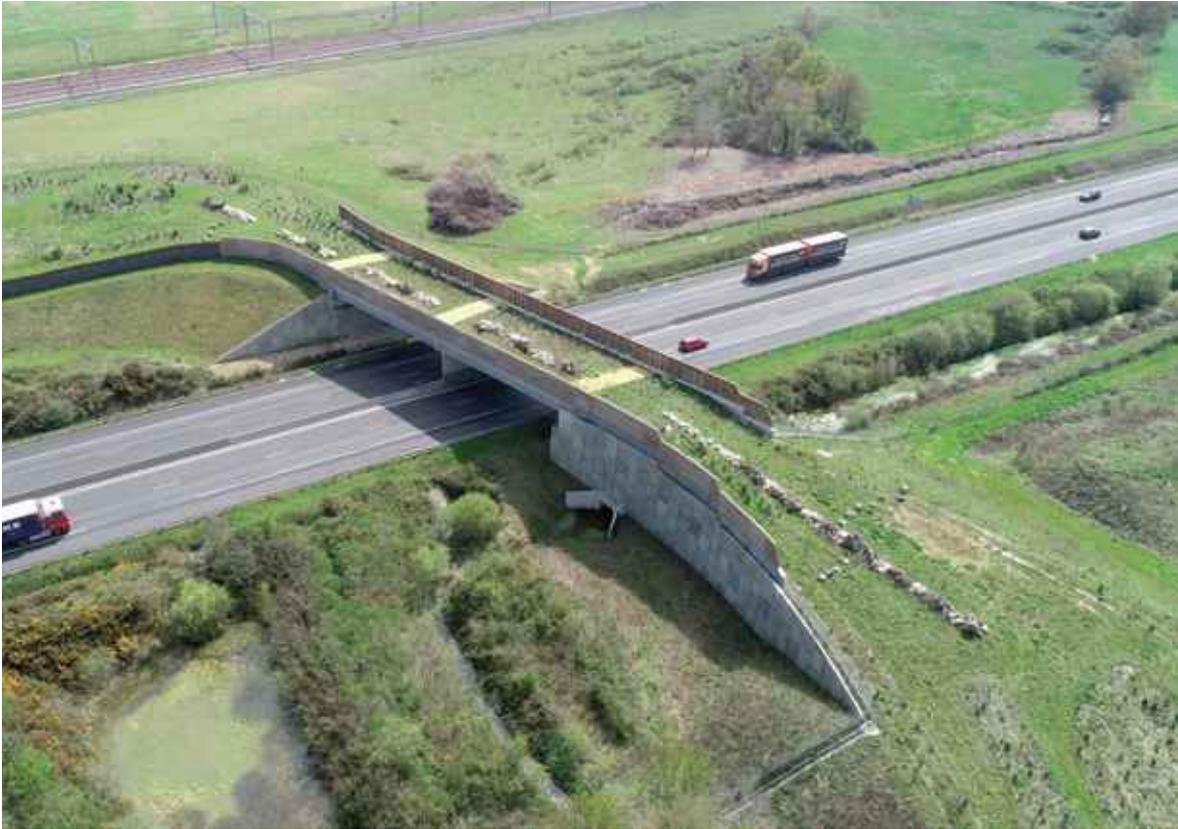
Figure 14 : Cas d'un ouvrage en remblai (Bas-Bry - Cofiroute). Les écrans occultants sur l'ouvrage sont prolongés hors ouvrage au droit des murs en retour et en accompagnement du début des rampes d'accès sur les longueurs d'environ 15 mètres de part et d'autre de l'ouvrage. ©VCT.
