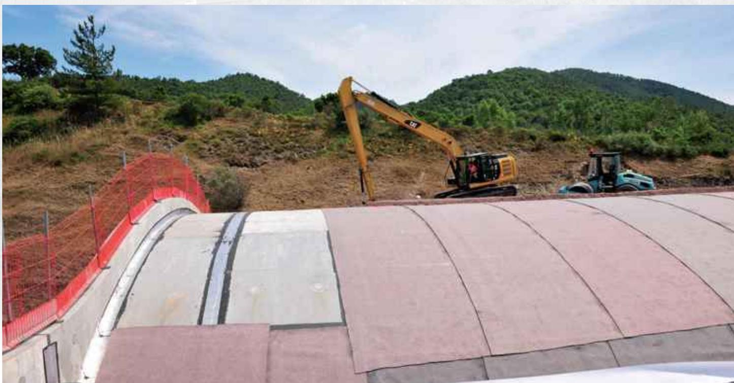
Figure 11 : Tablier d'un écopont avant son recouvrement en matériaux. ©M. MARTINI.
