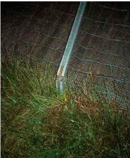
Figure 15 : Rupture des poteaux de la clôture équipée de panneaux de bande à la suite de la tempête ANA en 2017. ©VINCI Autoroutes.
