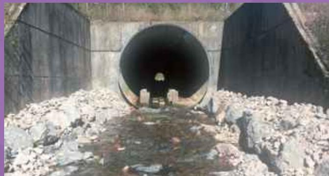
Figure 39 : Avant/Après: La fosse de dissipation a été comblée, la chute de 40 centimètres en sortie de buse supprimée, et des rugosités ont été ajoutées à l'intérieur de la buse pour influencer sur la vitesse d'écoulement. ©Photothèque VINCI Autoroutes
