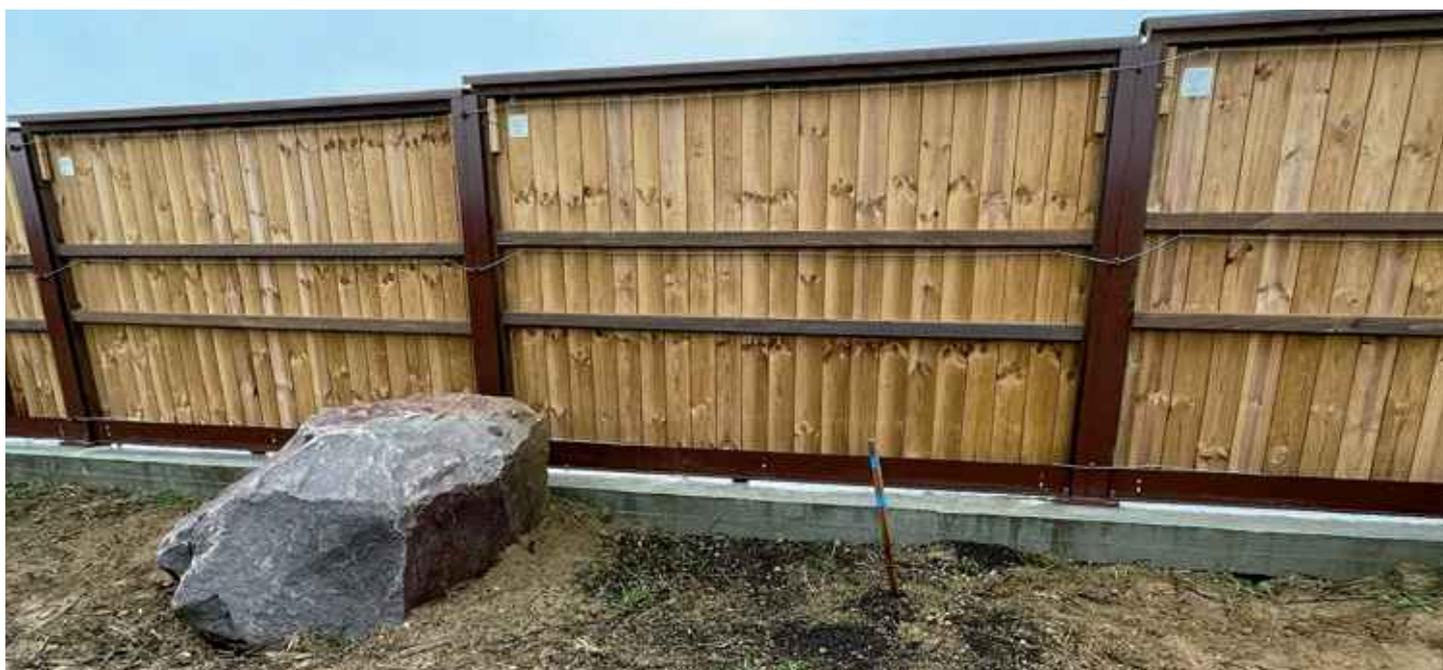
Figure 13 : Sur le contournement ouest de Strasbourg, les panneaux sont liés entre eux par un câble métallique et reliés au sommet des montants métalliques. Dans le cas d'une éventuelle rupture d'un des éléments, cela permet d'éviter une chute sur les voies (câble de 4 mm de diamètre en inox). ©VINCI Autoroutes.
