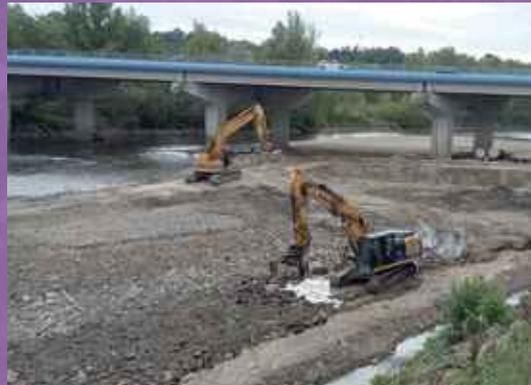
Figure 41 : Les travaux sont réalisés de manière progressive depuis une berge vers l'autre, dans le lit en amont du seuil et nécessitent le déplacement de blocs volumineux pour la formation de la rampe. ©Photothèque VINCI Autoroutes
