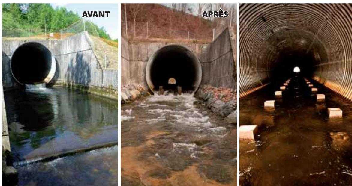
Figure 83 : Présentation de la buse avant travaux (à gauche) et après travaux (au centre et à droite). Source ASF.
