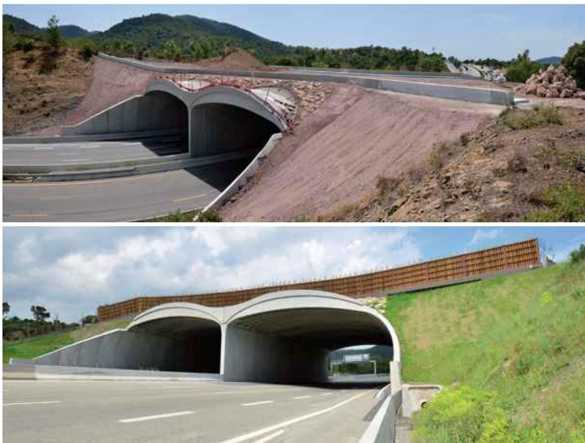
Figure 21 : La végétalisation par ensemencement des talus des ponts à doubles voûtes permet d'éviter le ravinement. ©M. MARTINI.
