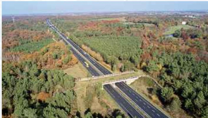
Figure 10 : Écopont Forêt de la Lande A10. ©MOULET.
