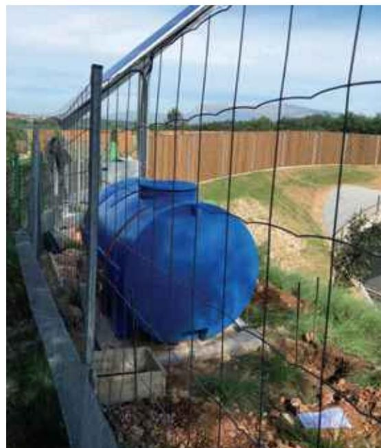
Figure 20 : Installation d'une cuve de stockage équipée d'un panneau solaire et alimentée par un forage. ©Cabinet X-AEQUO.
