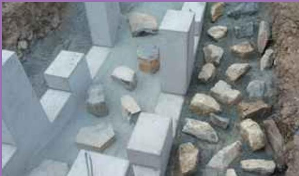
Figure 36 : Réalisation d'une planche test de la disposition des macro-rugosités disposées en quinconce et séparées par des blocs de roches saillants (+/- 10 centimètres). ©Photothèque VINCI Autoroutes
