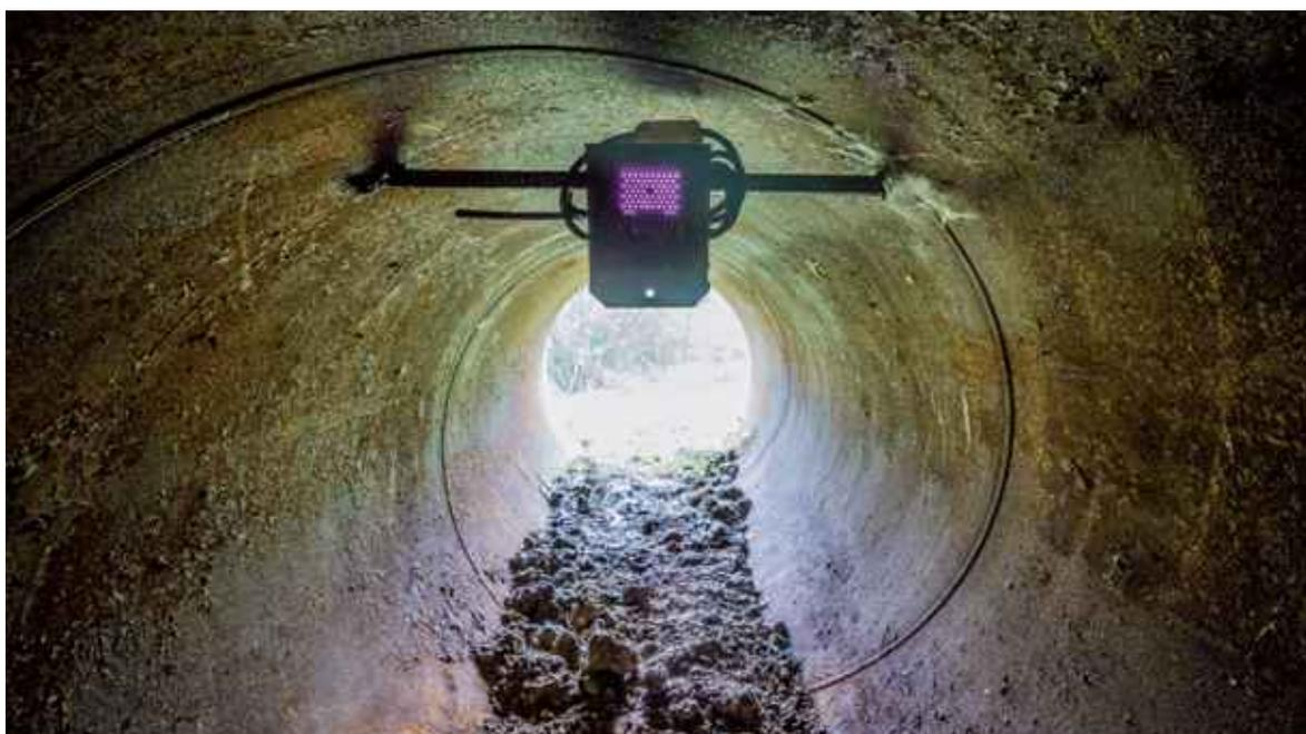
Figure 35 : Exemple d'un substrat argileux en mottes sèches dans un écoduc de 120 centimètres de diamètre. ©Alexis Orseau/LPO France.
