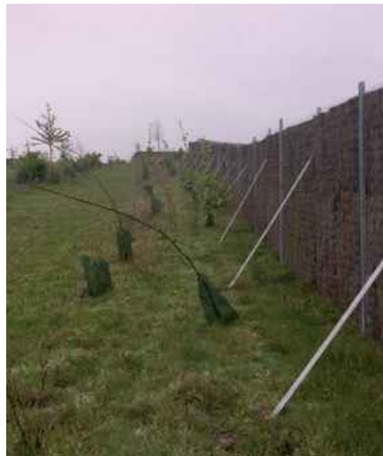
Figure 16 : Dans le cas d'utilisation de la bande pour les brise-vues, renforcer la clôture à l'aide de jambes de force réparties à distances régulières (tous les deux poteaux de clôtures). ©VINCI Autoroutes.
