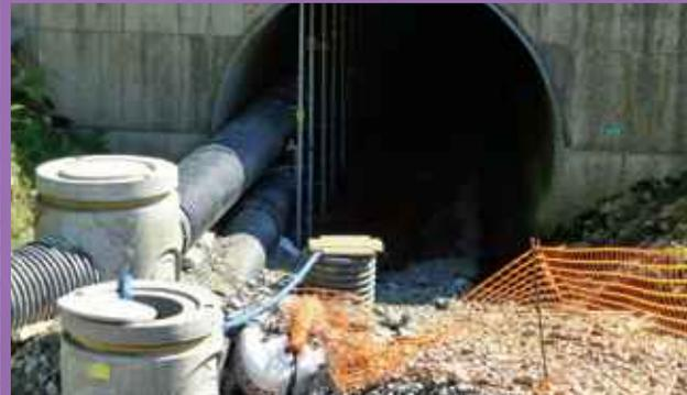
Figure 38 : Mise en place de batardeaux et dérivation du cours d'eau pour permettre un travail en assec. ©Photothèque VINCI Autoroutes
