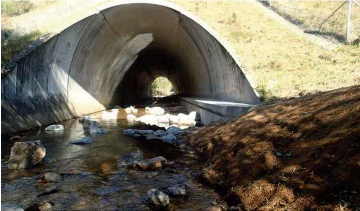
Figure 86 : Vue générale de l'ouvrage du Deiro et son réaménagement pour la petite faune (photos prises en phase de chantier). ©GREGE.
