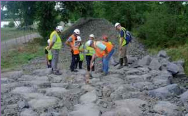
Figure 40 : Réalisation d'une planche de test pour la création de la rampe destinée au franchissement de la faune piscicole et aux canoës. ©Photothèque VINCI Autoroutes
