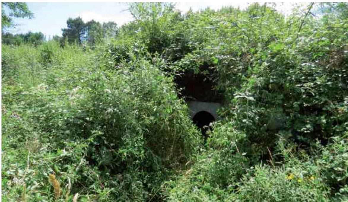
Figure 58 : entrée d'un écoduc de 80 centimètres de diamètre envahi par la végétation et rendant le suivi du piège photo de l'entrée impossible. ©ASF/LPO France.
