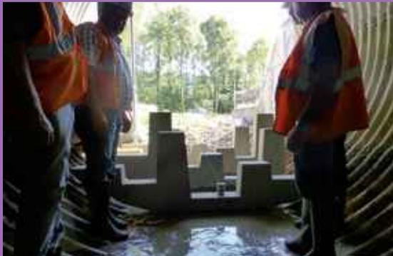
Figure 37 : Mise en place de macro-rugosités en fond d'ouvrage pour permettre de diminuer la vitesse d'écoulement et de créer des zones de repos pour la faune piscicole. ©Photothèque VINCI Autoroutes
