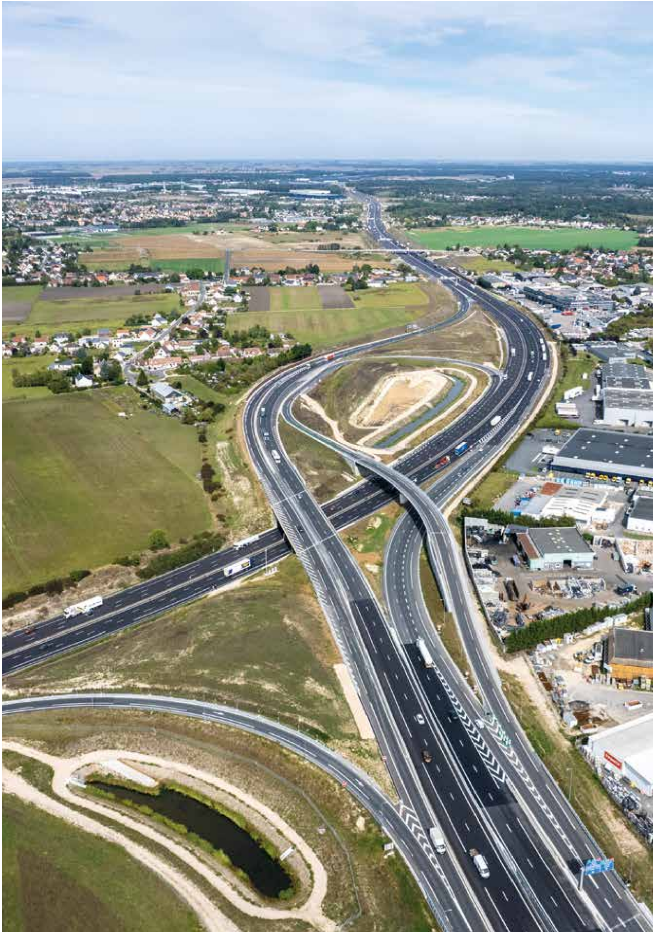
Réaménagement de la bifurcation A10/A71 au nord d'Orléans réalisé dans le cadre du Plan de relance autoroutier. Cette opération est allée de pair avec la création d'une quatrième voie sur l'A10 dans les deux sens de circulation.
