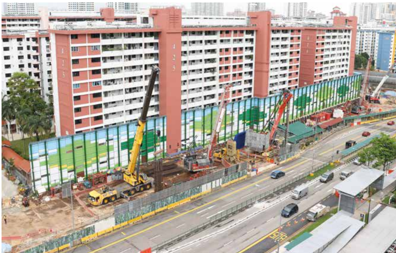
À Singapour, Soletanche Bachy réalise l'extension de la station de métro Ang-Mo-Kio, avec ses six entrées, ses deux passages souterrains par microtunnelier, sa tranchée couverte et ses deux tunnels creusés au tunnelier. Ce projet mobilise le tout nouveau modèle d'Hydrofraise® (HF8c) développé par Soletanche Bachy.
