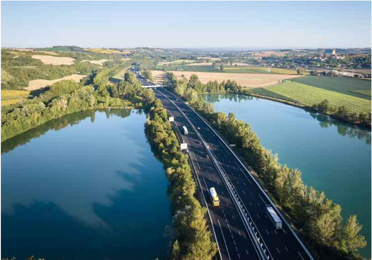
Aménagement à 2x3 voies de l'A61 sur 35 km entre Toulouse et Narbonne. Ici, à proximité des aires de Port-Lauragais.
