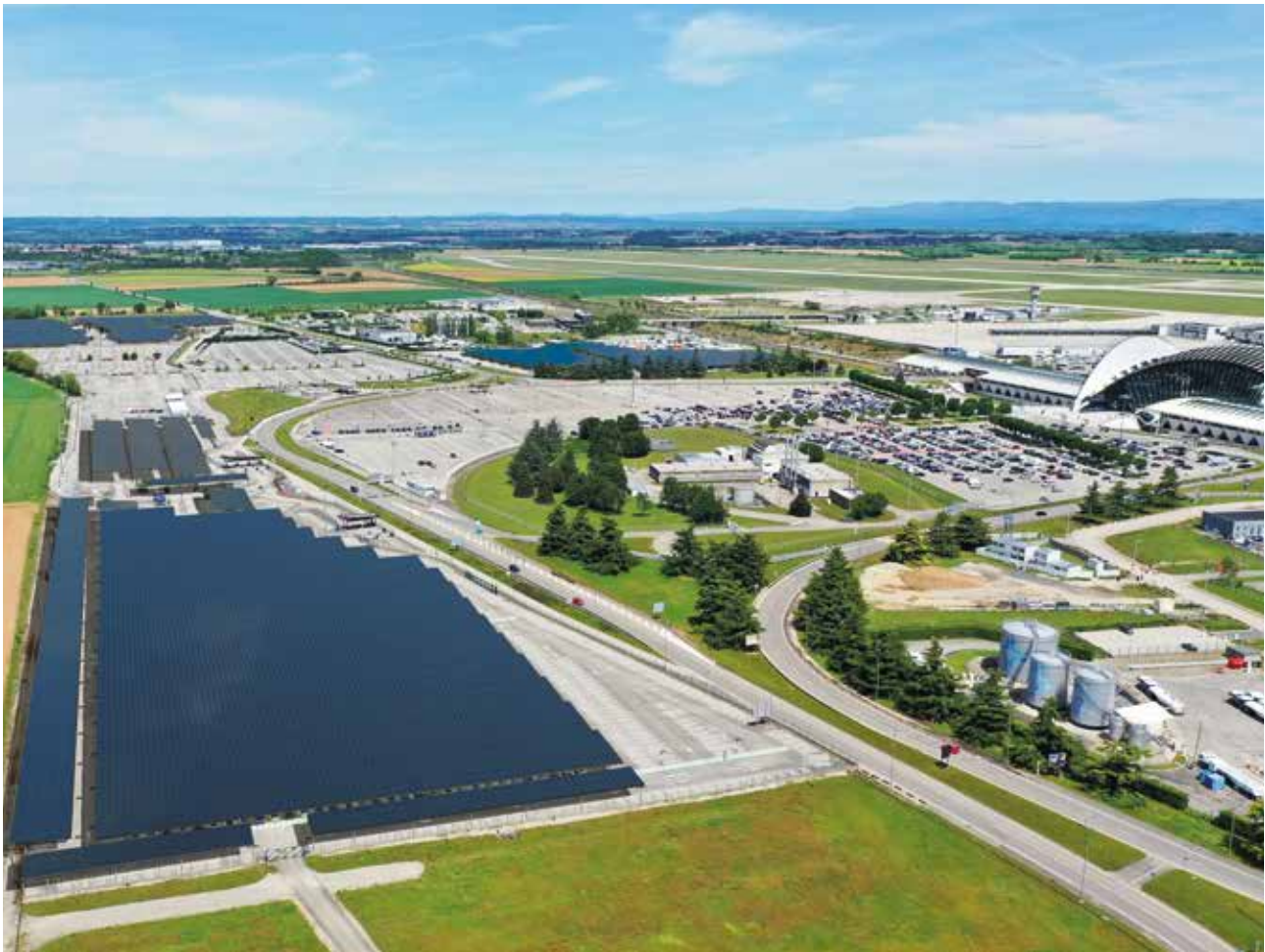
À l'aéroport Lyon-Saint Exupéry, SunMind, filiale de VINCI Concessions, en partenariat avec Neoen, déploie l'une des plus importantes centrales en ombrières du pays - 14 ha, pour une capacité de 20 MWc (image de synthèse).
