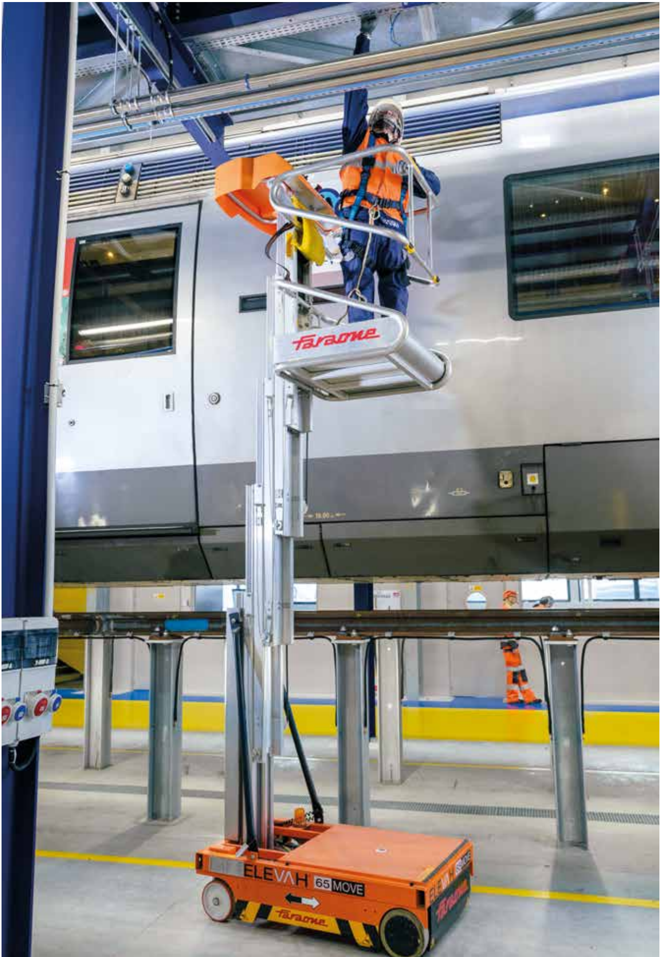
Les équipes d'Actemium réalisent la maintenance de 14 des technicentres de la SNCF (France).
