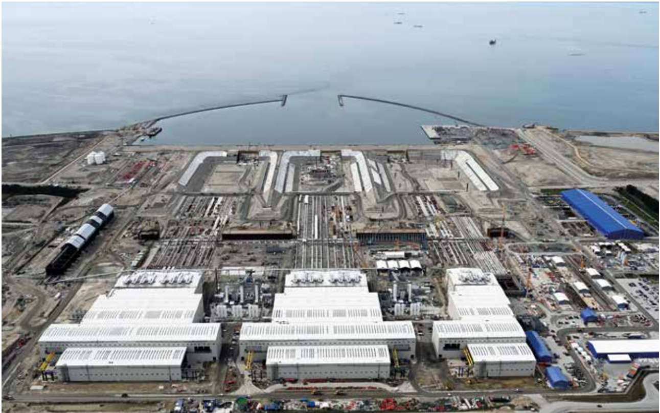
Au Danemark, la construction de l'usine de préfabrication des 89 caissons qui formeront le tunnel du Femern, plus long tunnel immergé du monde, s'est achevée en août 2023.
