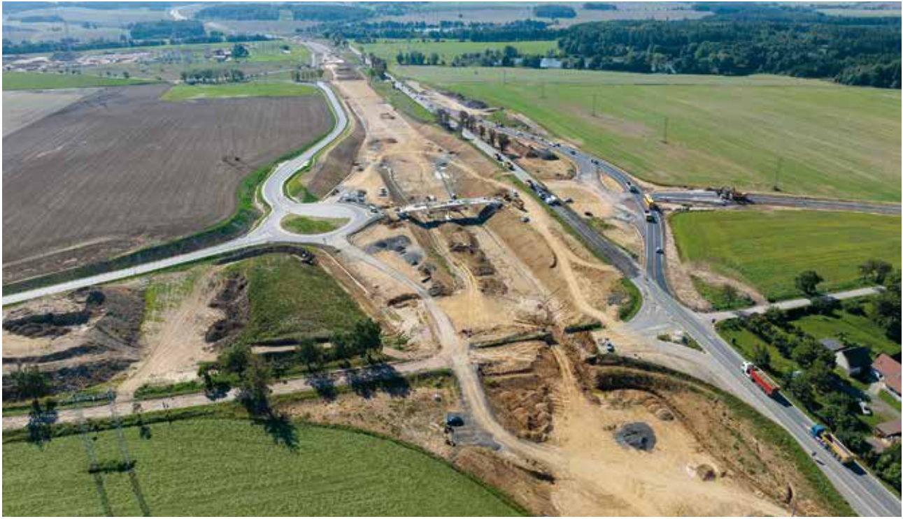
Eurovia CS réalise les travaux de l'autoroute D4 dans le cadre du premier partenariat public-privé autoroutier en République tchèque (dont VINCI Highways est concessionnaire). Cette nouvelle liaison améliorera la connexion entre la région rurale de Bohême du Sud et Prague.
