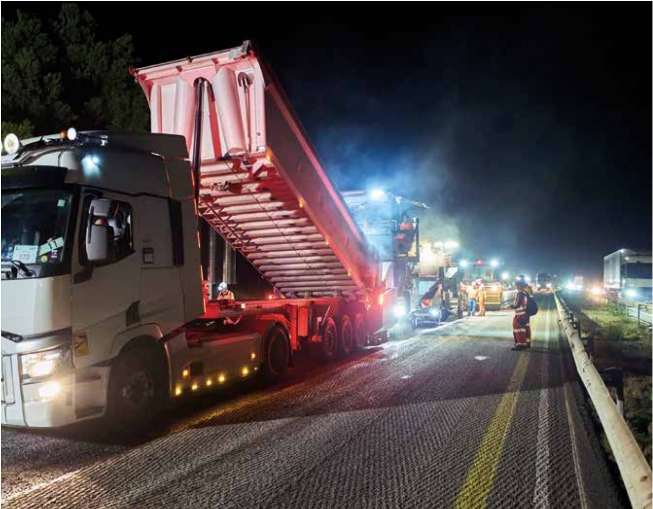
Sur ce chantier de rénovation de chaussée de l'A61 entre Carcassonne et Lézignan, une grande partie des agrégats d'enrobés de l'ancienne chaussée a été réincorporée dans la nouvelle.
