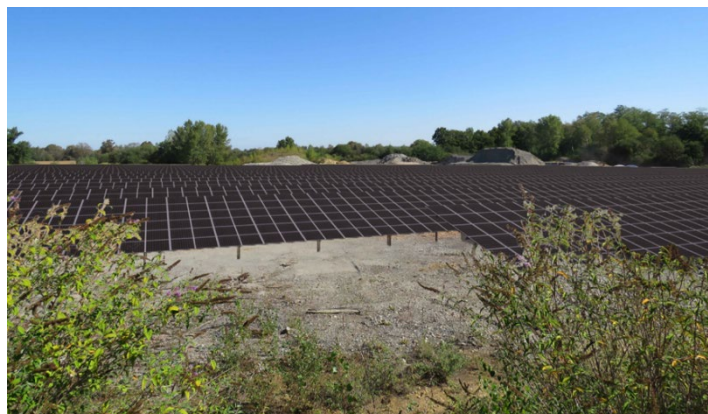
Vue du projet depuis le haut du merlon sud
