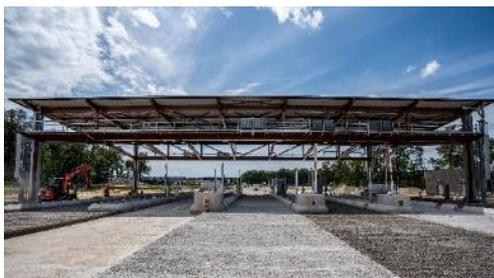
D'une superficie de 1 200 m<sup>2</sup>, l'auvent permet par ailleurs de récolter et d'acheminer les eaux de pluie jusqu'à une cuve de 70 m<sup>3</sup> enterrée à proximité.
