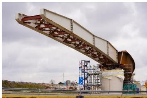
Ouvrage d'art non courant de type caisson mixte ouvert, le « saut-de-mouton » mesure près de 122 mètres de long et 9 mètres de large. Il porte désormais la bretelle d'entrée sur l'A10 en provenance de Vierzon et à destination de Tours. 13 caissons métalliques forment la charpente de l'ouvrage pour un poids total de 550 tonnes.
