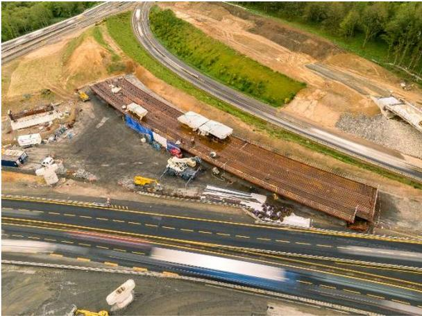
Mai 2023 – Assemblage et soudage de la charpente du viaduc est.
