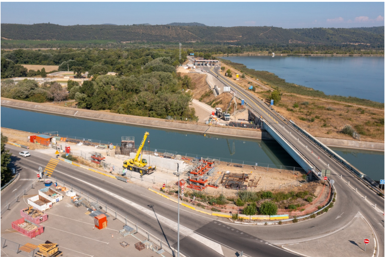
La zone de chantier en date du 25 août 2023.
