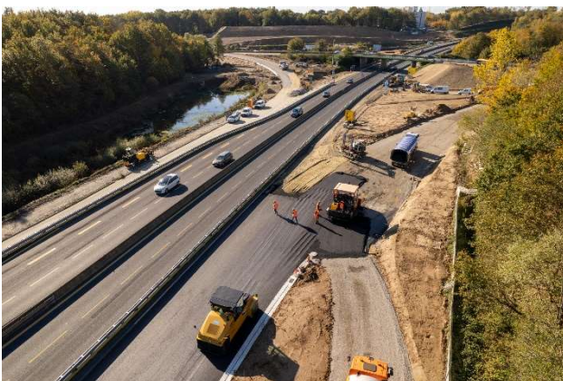
Novembre 2021 – Mise en œuvre des enrobés et mise en circulation de la boucle provisoire pour assurer la liaison entre l'autoroute A11 et la boucle provisoire et permettre le maintien de la circulation pendant toute la durée des travaux.
