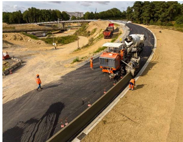
Juillet/Août 2023 – Mise en œuvre des enrobés sur la bretelle et le viaduc ouest. Pose des dispositifs de sécurité avec la mise en place d'un muret en béton le long de la bretelle.
