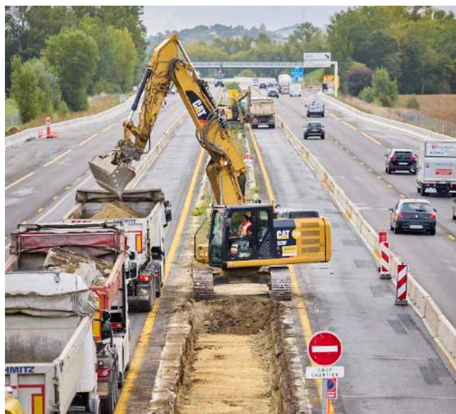
Zone centrale du chantier, sécurisée par des séparateurs de voies en béton.
