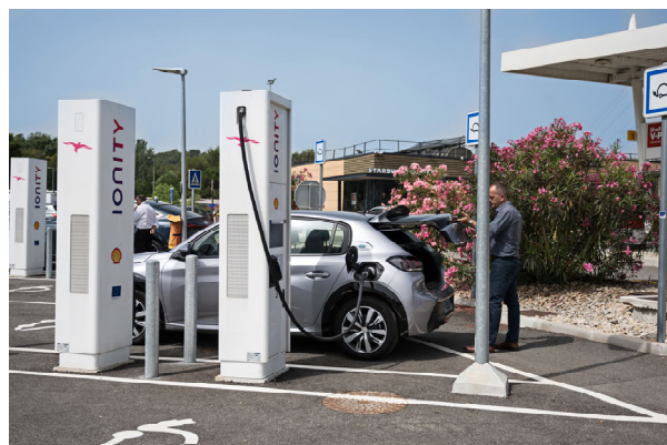
Aire de Bréguières Nord (A8) @Photothèque VINCI Autoroutes
