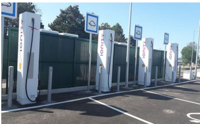
Aire de Montélimar Est (A7) @Photothèque VINCI Autoroutes
