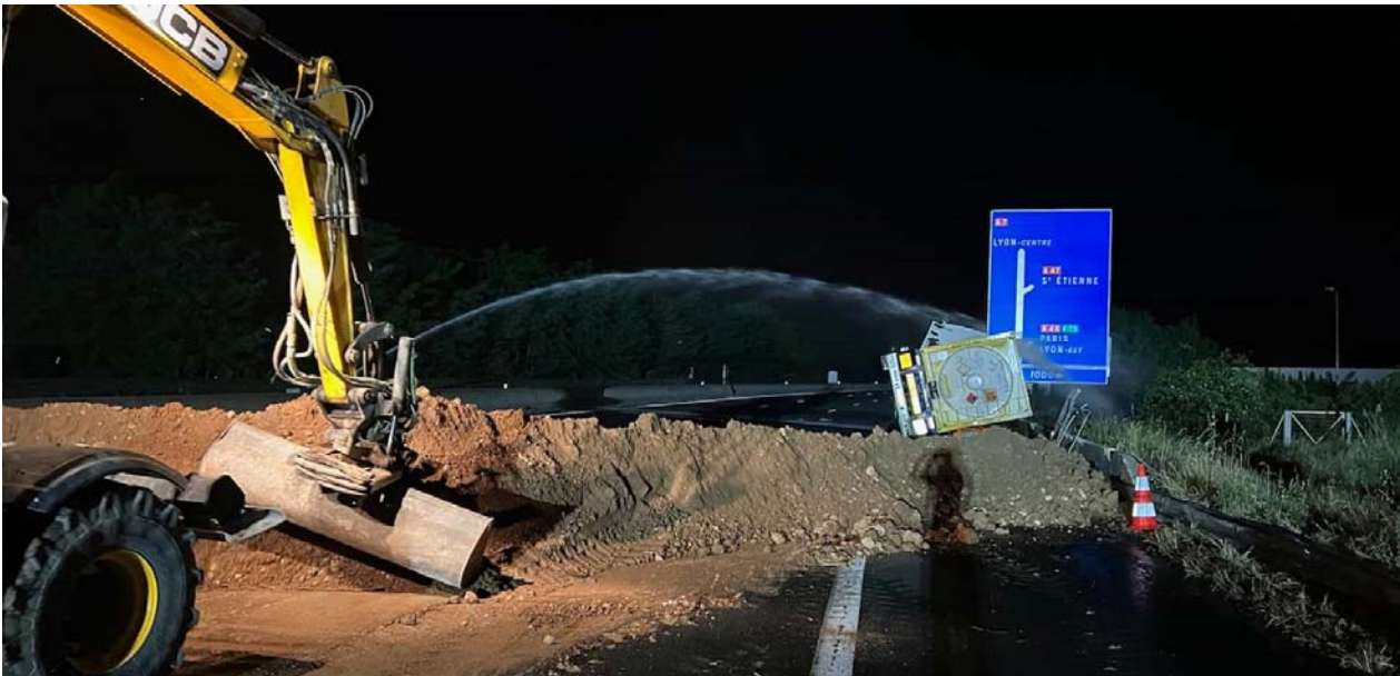
60 tonnes de terre ont été acheminés pour permettre la mise en place d'un merlon de protection autour du poids lourd accidenté avant son relevage par une grue.
