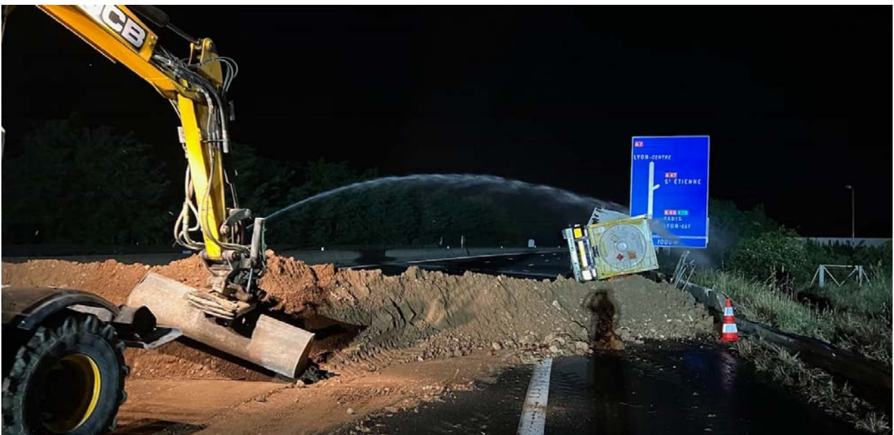
60 tonnes de terre ont été acheminés pour permettre la mise en place d'un merlon de protection autour du poids lourd accidenté avant son relevage par une grue.
