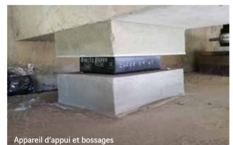
Appareil d'appui et bossages
