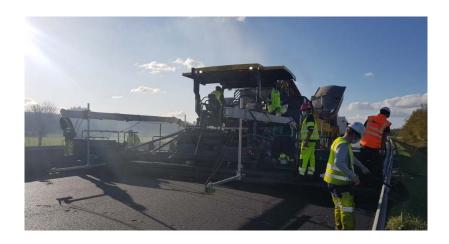
VINCI Autoroutes réalise des travaux sur la chaussée de la sortie n°6 - Connerré. La couche supérieure, dite couche de roulement, doit être refaite dans une des bretelles. Afin de permettre la réalisation de ces travaux, la sortie en provenance du Mans sera fermée le mercredi 2 mars de 8h à 12h.
