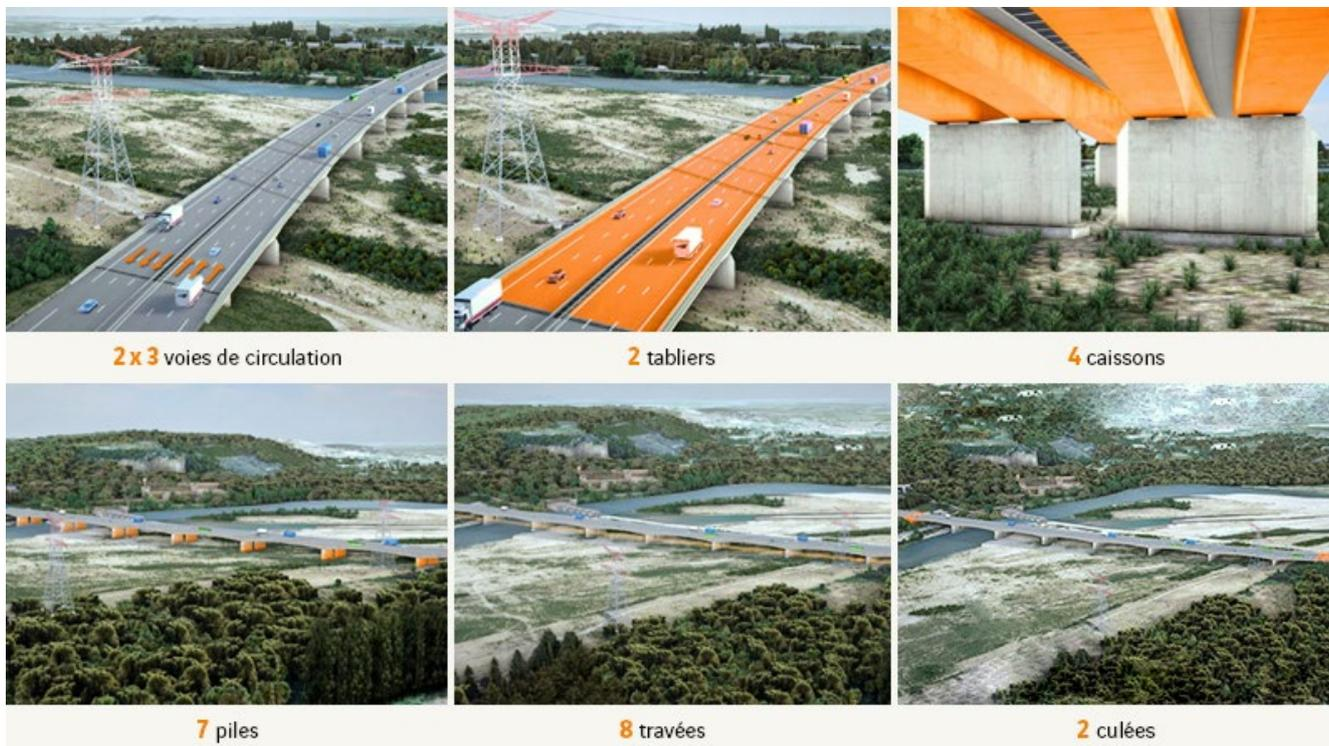
**Les travaux sont réalisés dans le cadre de la politique d'entretien et de maintenance déployée par VINCI Autoroutes. Ils consistent à renforcer les deux tabliers, à remplacer les appareils d'appui et à changer le joint de chaussée.**
