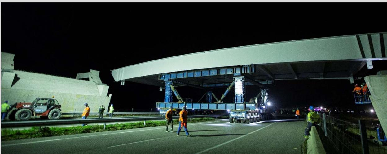
Mise en place du tablier du nouveau pont la nuit du 19 décembre 2019, sous fermeture de l'A52 (photo Guilhem Canal).
