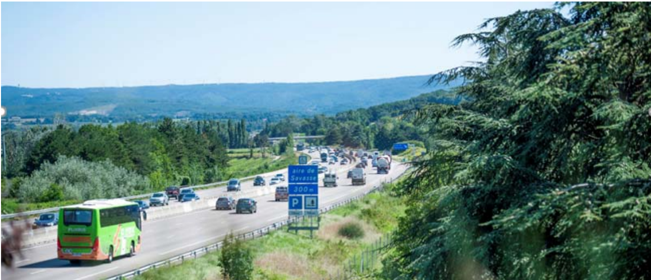
Autoroute A7 dans le secteur de Montélimar @ VINCI Autoroutes
