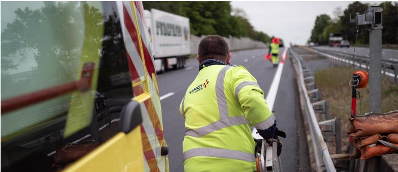
Les équipes posent le balisage du chantier nécessaire au basculement de la circulation (photo prise le 5 mai 2021).
