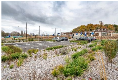
Vue du Parc multimodal de Longvilliers © Caroline Gasch pour VINCI Autoroutes
