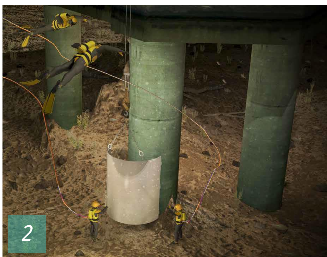
Pose des viroles métalliques.
