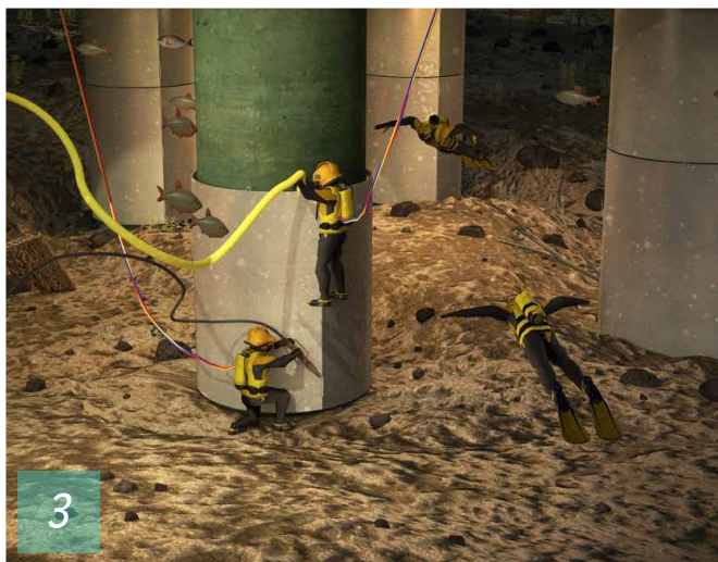
Bétonnage entre la virole et le pieu (lutte contre la corrosion).
