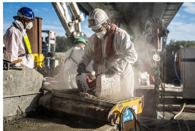
La préparation du mortier est réalisée sur le ponton.
