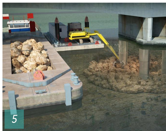
Mise en œuvre des enrochements au fond du fleuve.
