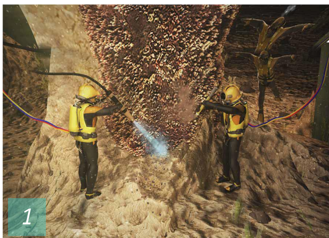
Nettoyage, grattage des pieux des piles avec de l'eau pulsée à haute pression.
