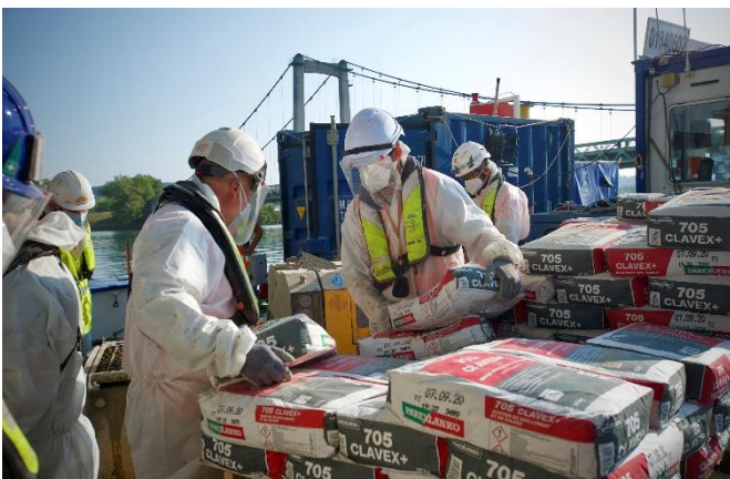
La préparation du mortier est réalisée sur le ponton.
