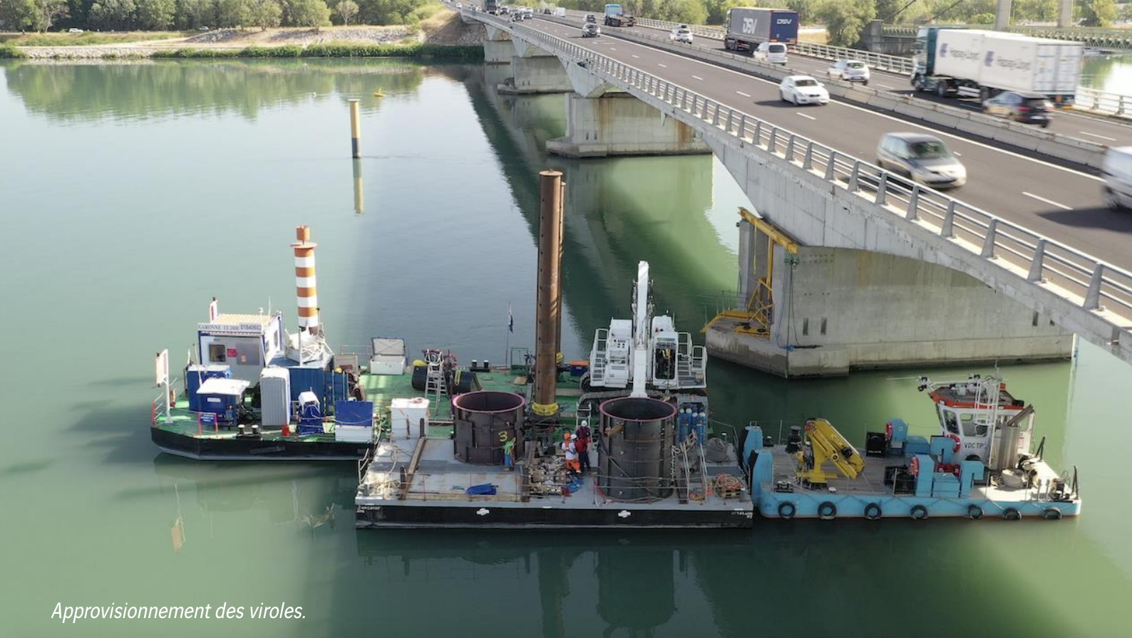
Équipés de caméras les scaphandriers contrôlent la bonne mise en place des viroles autour des pieux. En surface depuis la barge les images sont visionnées en direct pour vérifier chaque étape de ce chantier.
