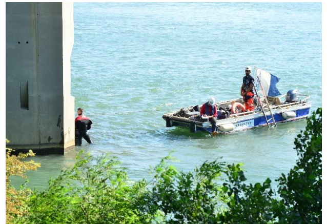
Inspection des piles par des plongeurs (2018).
