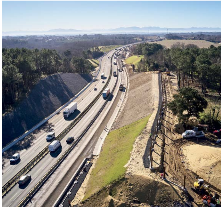
Travaux d'élargissement à 2x3 voies de l'A63 entre Ondres et Saint-Geours-de-Maremmes (Landes), réalisés dans le cadre du Plan de relance autoroutier.
