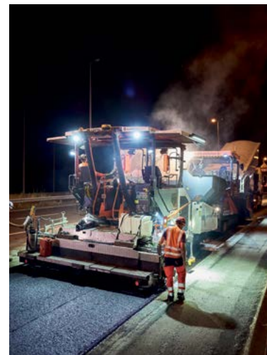
1 et 2. Renouvellement d'enrobés sur l'A64 et l'A620, lors de campagnes d'entretien des chaussées.
