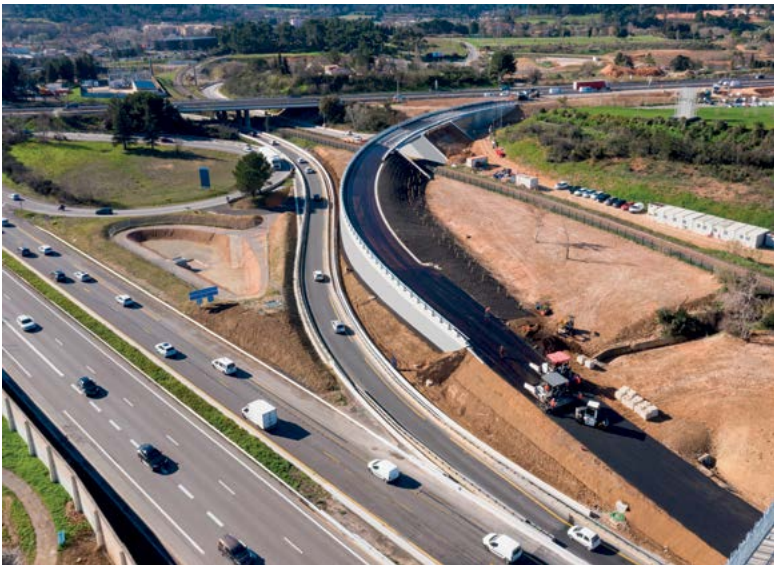
Réaménagement de la bifurcation A8/A51, à proximité d'Aix-en-Provence.
