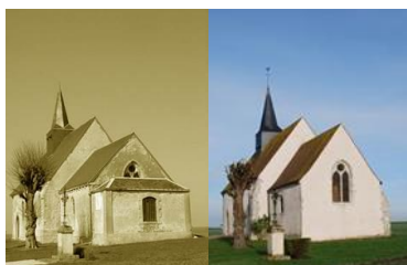
Restauration extérieure de l'église de Teillay
