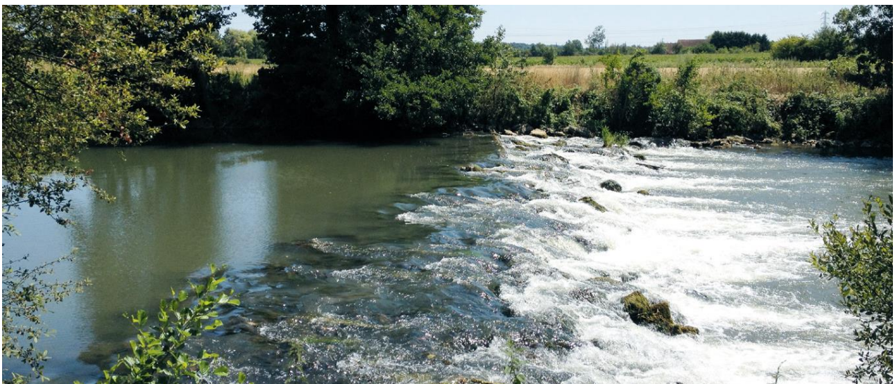
Seuil dans le lit du cours d'eau de l'Huisne @C.Gasch
