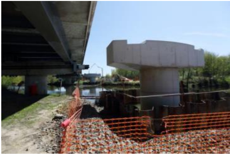
Pile marteau du viaduc de la Sauldre
