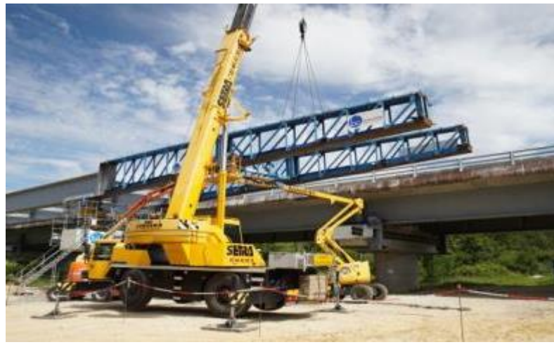
Lancement de la charpente métallique de 385 tonnes
