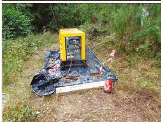
Photos n°47 : Kit anti-pollution, groupe électrogène sur cuve double fond avec bâche imperméable tout autour (de haut en bas). (© VINCI Autoroutes).
