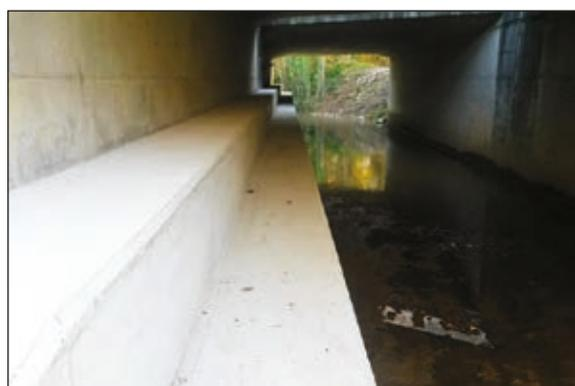
Photo n°10 : **Banquette double marche à l'intérieur d'un ouvrage hydraulique.** (© VINCI Autoroutes).
