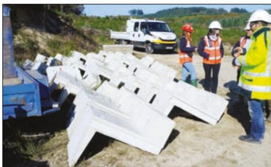
Photos n°34 : **Stockage d'éléments préfabriqués d'une banquette.** (© VINCI Autoroutes).
