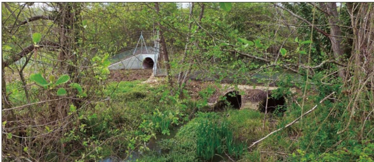
Photo n°7 : Aménagement d'un écoduc (buse sèche avec revêtement terreux) aux abords d'un ouvrage hydraulique.
