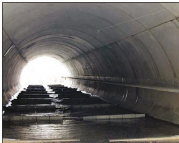
Photo n°9 : **Barrettes dans un ouvrage hydraulique aménagé avec un encorbellement.** (© Freyssinet).
