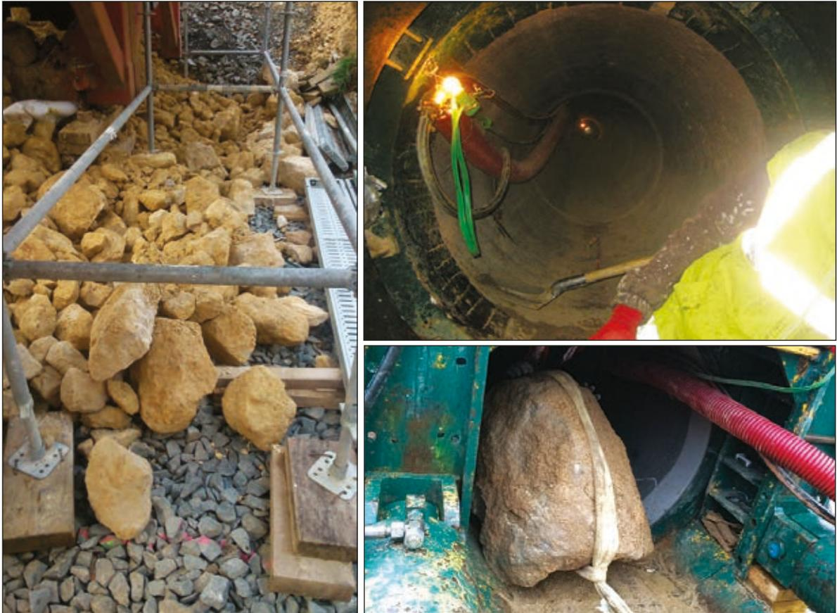
Photos n°29 : Technique de la tarière avec au 1<sup>er</sup> plan certains blocs de diamètre limite (gauche) sur A11, technique à front ouvert (haut, droite) et bloc massif excavé avec cette technique (bas, droite (A83)).
