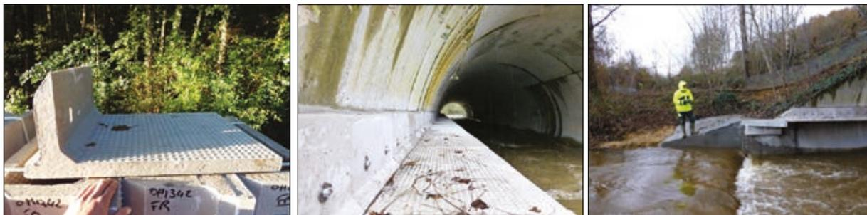
Photos n°43 : Encorbellement en béton polymère, encorbellement achevé dans l'OH et raccordement offrant une possibilité de passage depuis le pied et le haut de berge et ne générant pas un point dur à l'écoulement (de gauche à droite).
