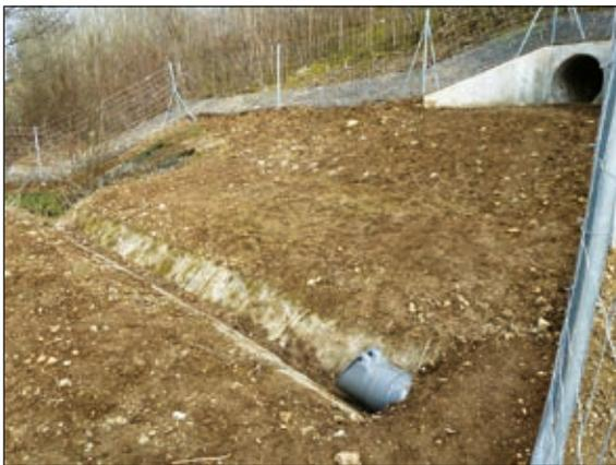
Photo n°31 : Dispositif de type clapet adapté dans certains cas uniquement (clôture franchissant un fossé).
