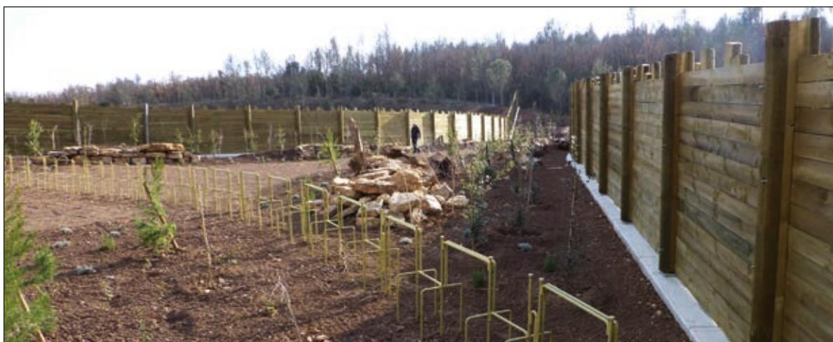
Photo n°40 : **Barrière métallique anti intrusion engin, mais perméable à la faune, sur un écopont.** (© VINCI Autoroutes).
