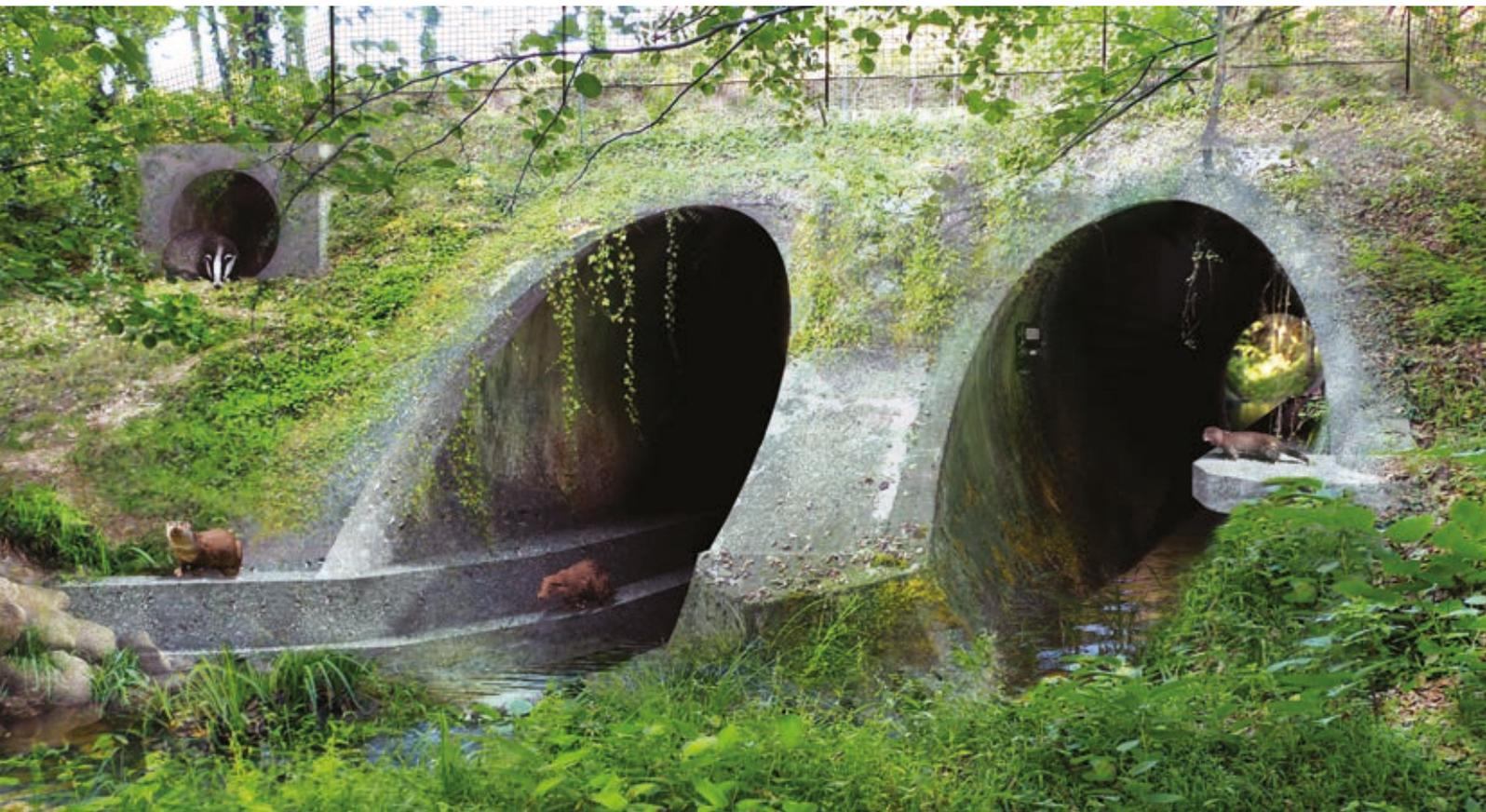
Photo n°4 : **3 types d'aménagement rétablissant les continuités écologiques : écoduc, banquette et encorbellement (de gauche à droite).** (© VINCI Autoroutes, L'Annexe)
