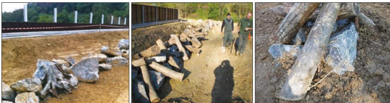
Photos n°38 : Réalisation d'andains ; on note le passage du câble sur la photo de droite (de gauche à droite). (© VINCI Autoroutes).
