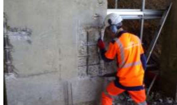
Réparation des bétons
