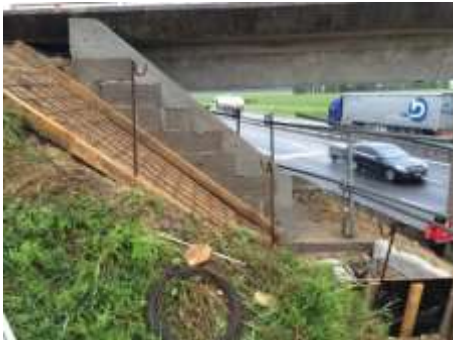
Création d'un escalier
