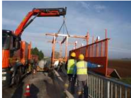
Remplacement des garde-corps
