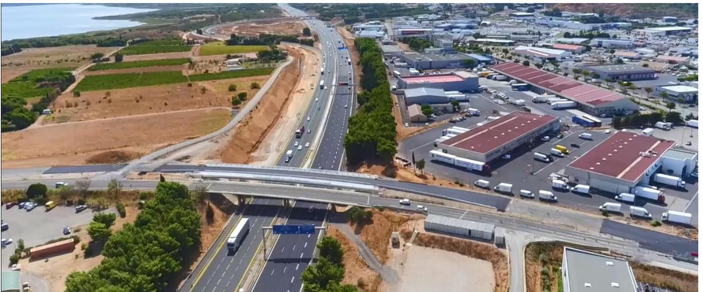
Le nouveau pont de la Nautique, construit juste à côté de l'ancien, enjambera les nouvelles voies de l'autoroute A9. Les travaux d'amélioration de la bifurcation offriront aux clients une jonction plus confortable entre les autoroutes A9 et A61 en direction de Montpellier, avec une augmentation du nombre de voies.
