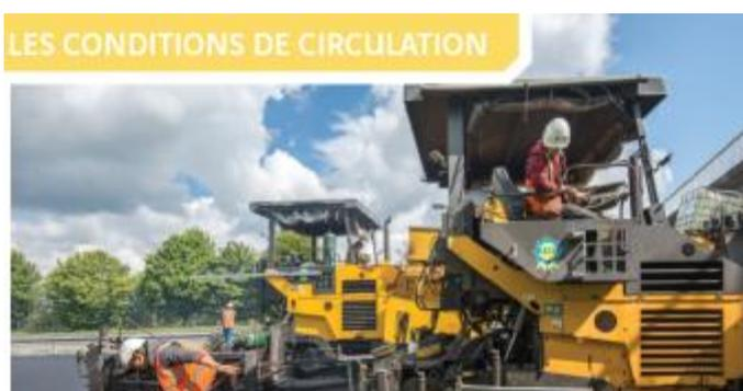
Cette opération consiste à augmenter la largeur de la voie de gauche de 3 mètres à 3,5 mètres, avec un élargissement par l'extérieur dans chaque sens de circulation.
