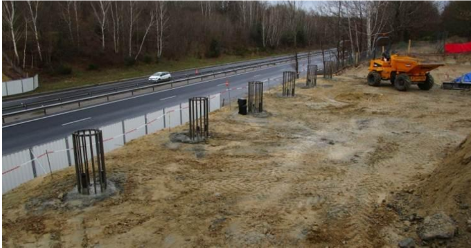
Réalisation des fondations profondes (pioux) d'un des deux appuis latéral.
