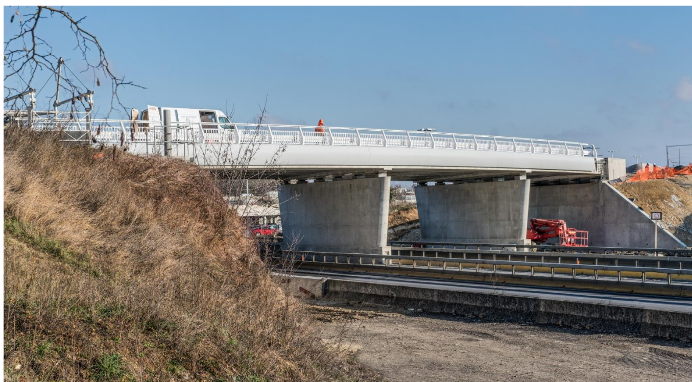
Le nouveau pont Maupas, derniers travaux avant la mise en service.
