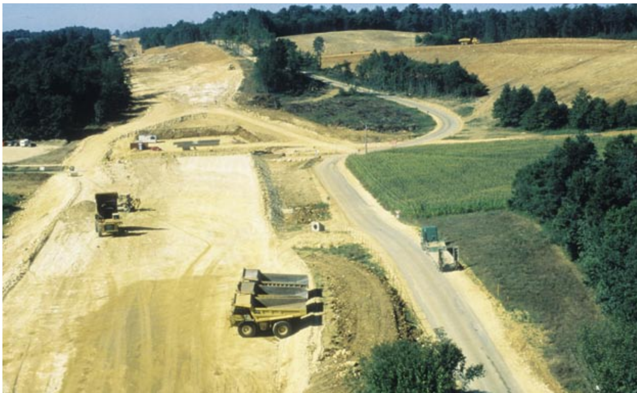
Chantier sur l'A89 Périgueux-Thenon.
