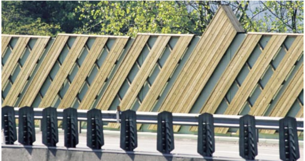
Mur antibruit sur l'A7.
