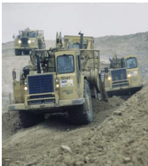
Engins de chantier sur l'A87.
