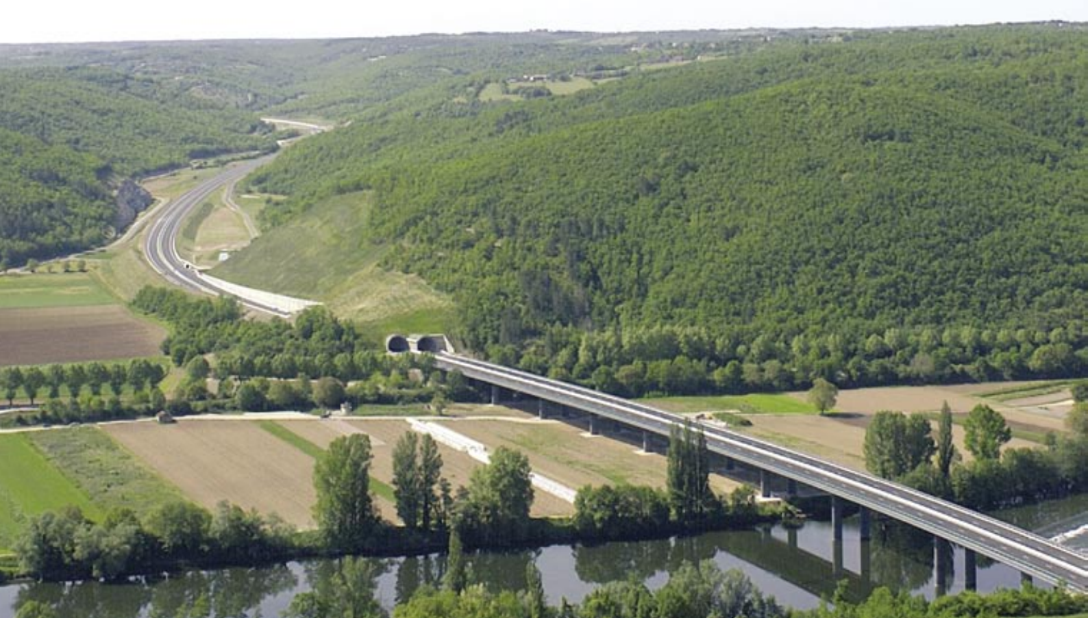
Viaduc du Lot et tranchée couverte de la Garenne sur l'A20.
