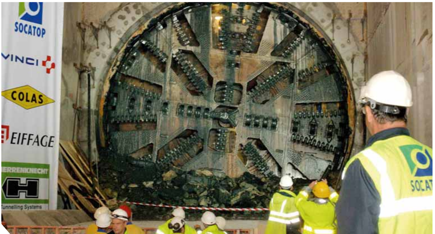
Fin du creusement du Duplex A86 le 23 août 2007, section Pont-Colbert - A13.
