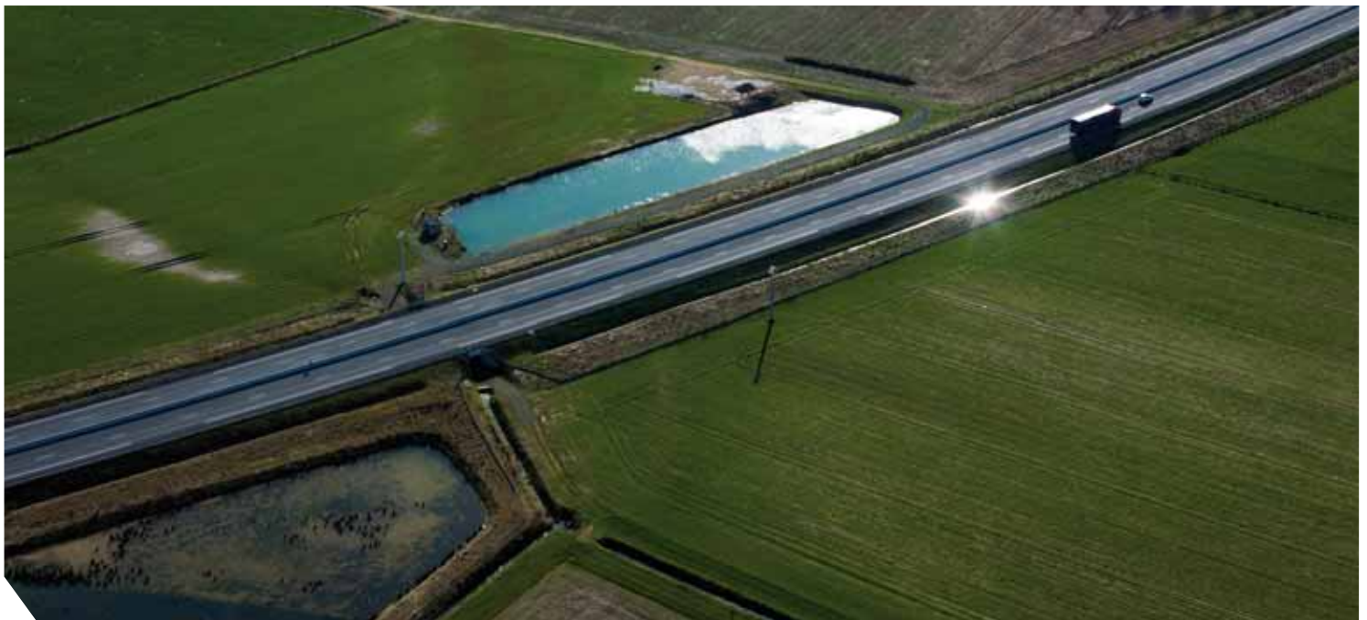
Bassin d'épuration des eaux pluviales.
