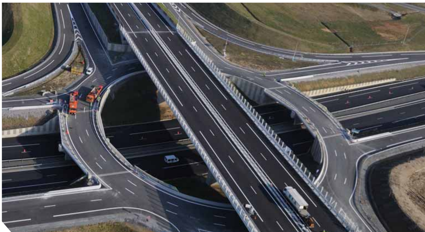
L'échangeur de la RD 106 (A11 Angers) : configuration à 3 niveaux permettant notamment de réduire les emprises de l'autoroute.
