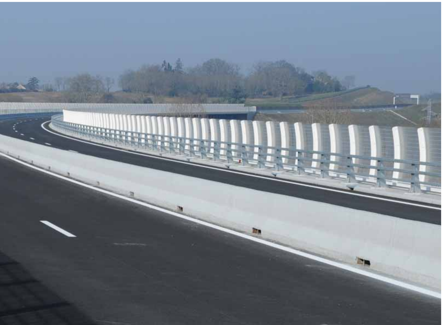
Le viaduc sur la Maine (A11 Angers).
