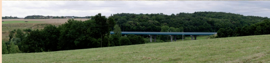
LE VIADUC DU BEUGNON EN PHASE CHANTIER (PHOTO DU HAUT) ET À LA MISE EN SERVICE (PHOTO DU BAS)
