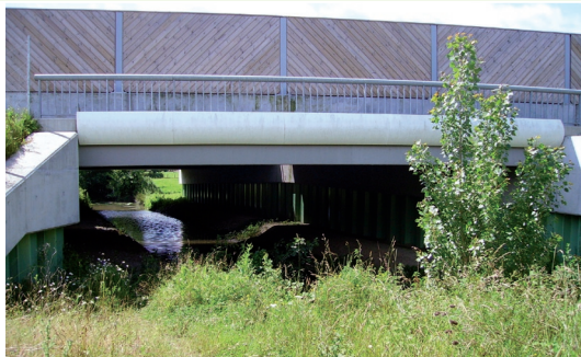
PASSAGE À GRANDE FAUNE LE LONG DU BRIONNEAU
