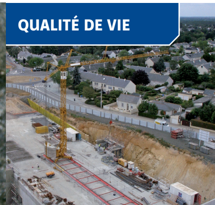
L'ENVIRONNEMENT DES RIVERAINS LORS DES TRAVAUX
