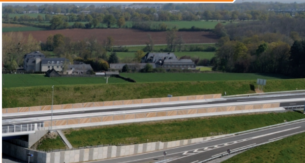
PROTECTIONS ACOUSTIQUES LE LONG DE L'AUTOROUTE
