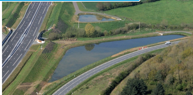
BASSINS DE DÉCANTATION
