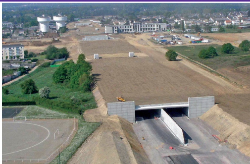
ENTRÉE OUEST DE LA TRANCHÉE COUVERTE
