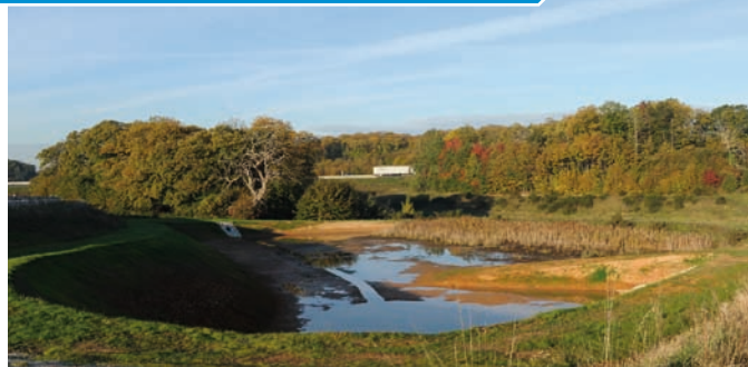
BASSIN DE TRAITEMENT DES EAUX
