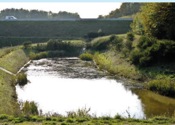
BASSIN DE TRAITEMENT DES EAUX
