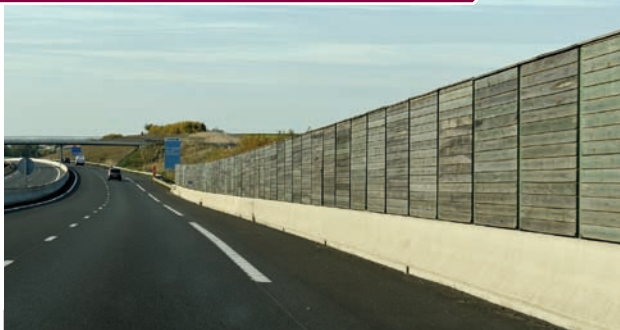
PROTECTIONS ACOUSTIQUES LE LONG DE L'AUTOROUTE
