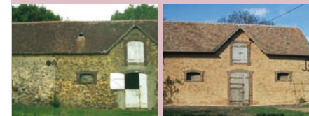
RESTAURATION DE CORPS DE FERME : AVANT ET APRÈS
