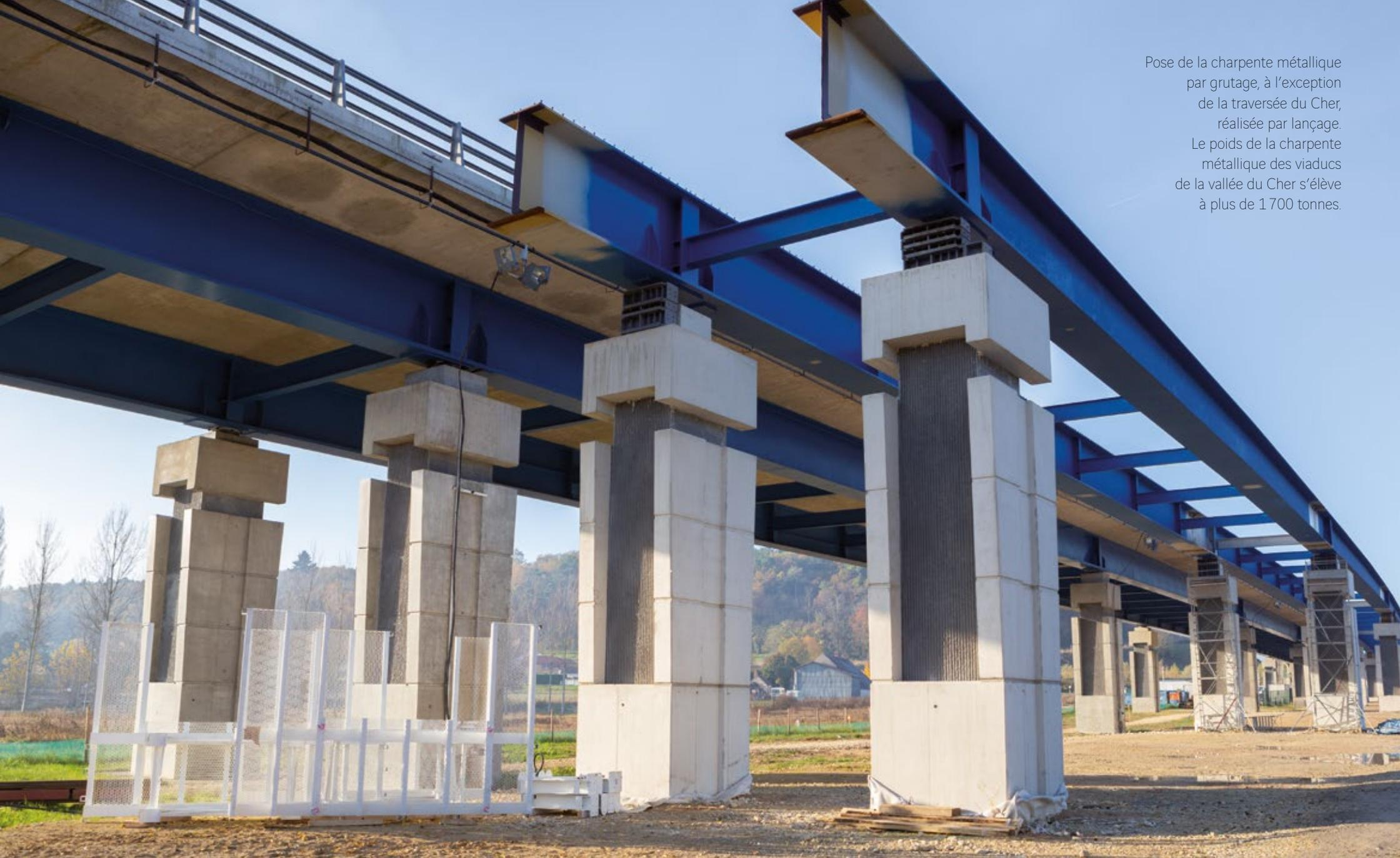
Pose de la charpente métallique par grutage, à l'exception de la traversée du Cher, réalisée par lançage. Le poids de la charpente métallique des viaducs de la vallée du Cher s'élève à plus de 1 700 tonnes.
